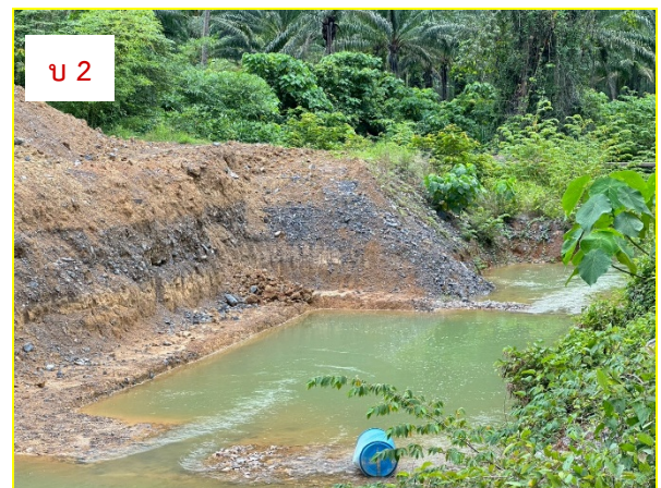
ภาพที่ 4-1 บ่อดักตะกอนของโครงการจำนวน 5 บ่อ
