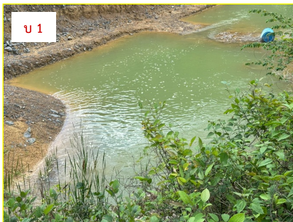
ภาพที่ 4-1 บ่อดักตะกอนของโครงการจำนวน 5 บ่อ
